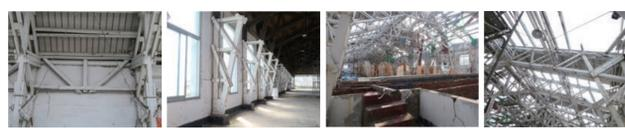
兩棟飛機維修廠，其在結構系統可分為內部山形構架與外部承重磚牆兩結構系統討論，山形構架主要由木桁架構成，構部分構件分為單根木料與雙根木料以螺栓夾鎖構成，構架之底部以鋼板與螺栓鎖固於基礎上。維修廠外牆為磚造承重牆構成之廣間型空間，牆體厚度達1.5B，在牆體頂緣設置有鋼筋混凝土圈樑，在開口部上方亦設置有鋼筋混凝土層樑。在山形構架與磚牆之連接點主要有四處配置於山形構架立柱上，透過預埋於磚牆內之L型角鐵，以螺栓與山形構架立柱鎖固。
