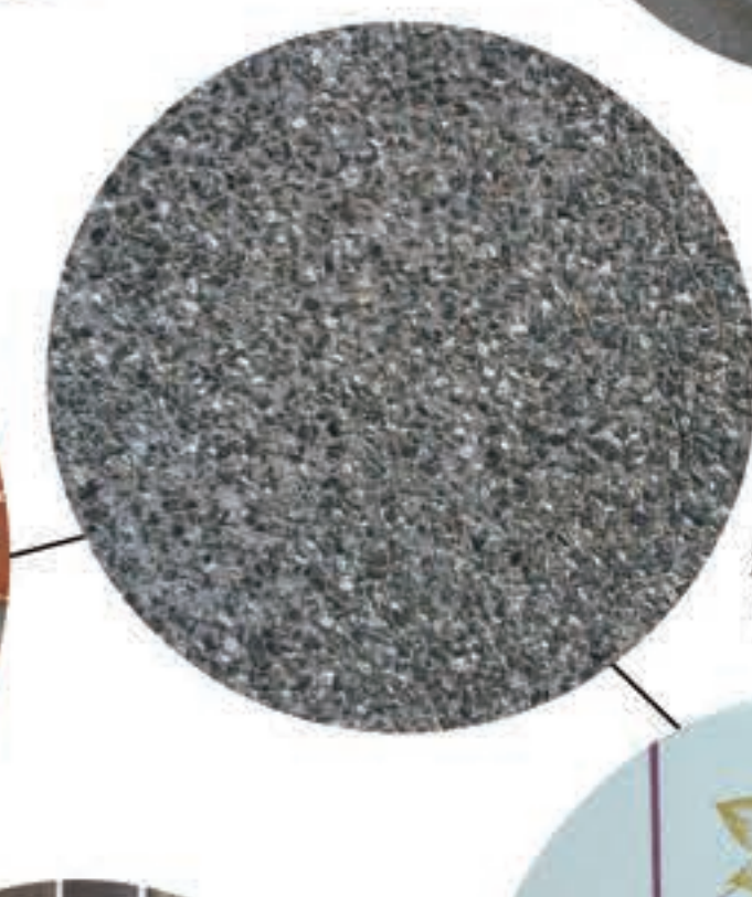
洗石子壁面 (攝於中和路49號1F)
